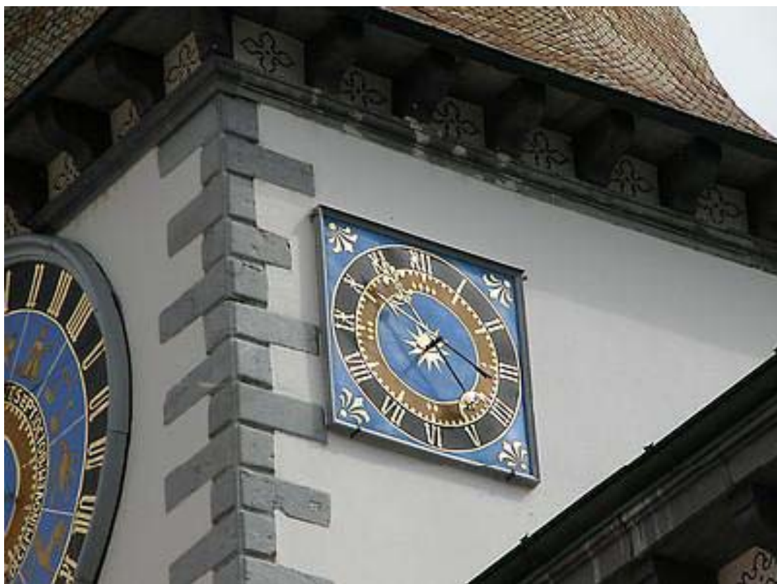
Figura n. 6: Sion, Palazzo Municipale, quadrante della facciata laterale destra.
